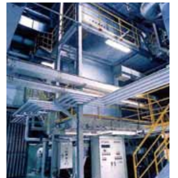
⑩脱硝反応塔 触媒による化学反応を利用して、排ガスから窒素酸化物を除去します。
