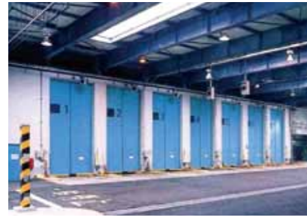
②プラットフォーム 収集車が、ごみピットにごみを投入する場所です。
