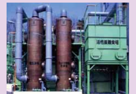
酸洗浄塔、アルカリ・次亜塩素酸ソーダ洗浄塔 活性炭脱臭塔
