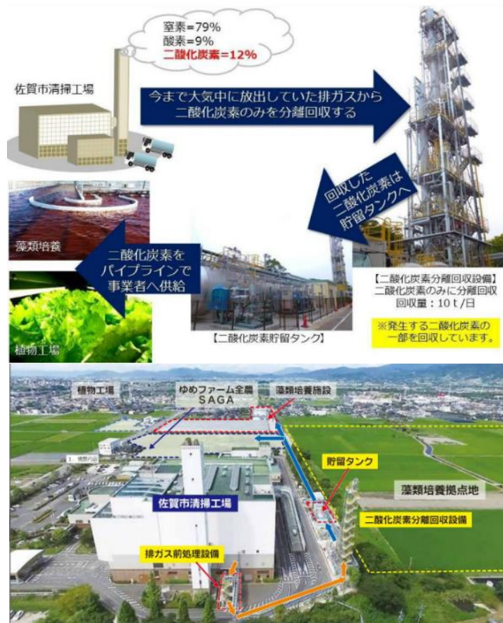
図 4-4-5 ごみ処理施設における CO 2 回収技術導入事例 (佐賀市)
